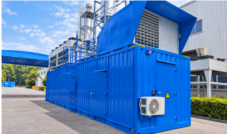
Außenansicht: Gehäuse, Kühlung und Lüftung
